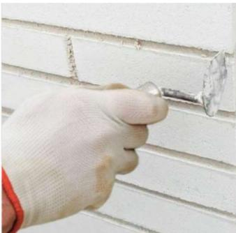
Le jointolement des plaquettes sera effectué avec un mortier de jointolement dont le module d'élasticité est < à 8 000 MPa. Le mortier de jointolement mis en œuvre sera le mortier Tradijoint de la marque Vpi
