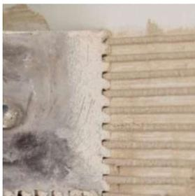
La pose de plaquettes de parement béton s'effectue par double encollage selon un dosage Collifaçade de 6,5 à 7 kg de poudre par m<sup>2</sup>.
