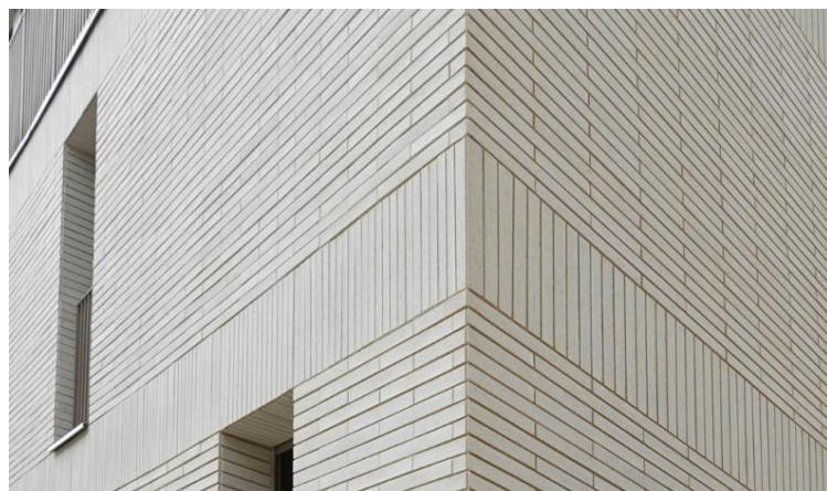
Rendu joint sec avec mortier joint creusé.
