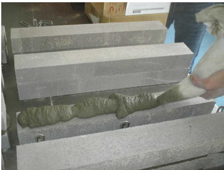
Photographie 2 : Détail de la mise en œuvre de la patte de fixation – mis en œuvre du mortier
