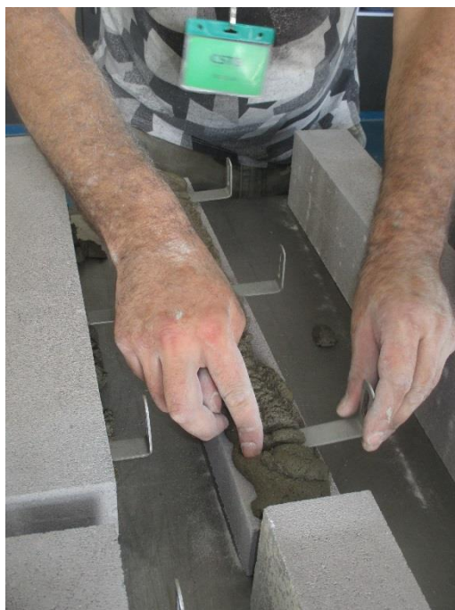
Photographies 3 et 4 : Détail de la mise en œuvre de la patte de fixation – mis en œuvre de la patte de fixation
