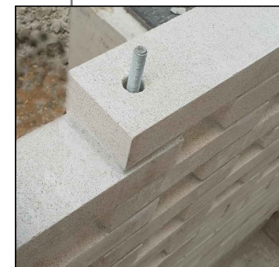
Moucharabieh en briques Am 90 contreventé par tige Inox traversante
