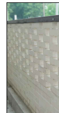
Moucharabieh en briques Am 90 contreventé par tige Inox traversante
