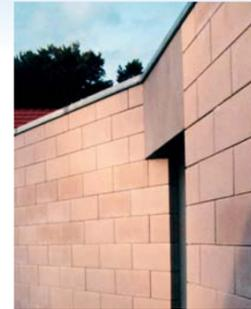
la réalisation des angles variables se fait avec des blocs d'abouts et demi-abouts armaturés, sans les harper (croiser).
