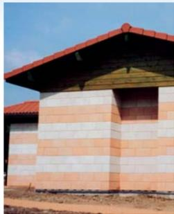
Les blocs sont emboîtés à sec, sans joints de mortier et sans mortier de liaisonnement
