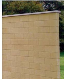
L'alvéole d'extrémité de ces deux blocs doit toujours être ferrillée et remplie de béton
