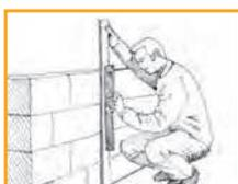
**Sur la verticale** à l'aide d'un fil à plomb ou d'une règle dotée d'un niveau à bulle.
