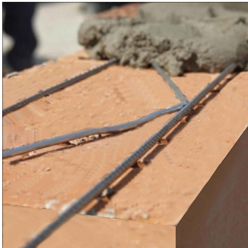
Armature pour maçonnerie type Murfor
