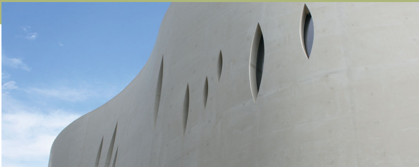
Médiathèque « Le Pavillon blanc » à Colomiers (31).
